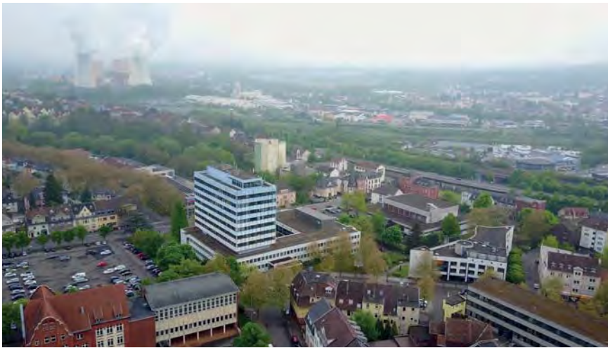
Verwaltungsquartier mit Rathaus und Stadtbad
